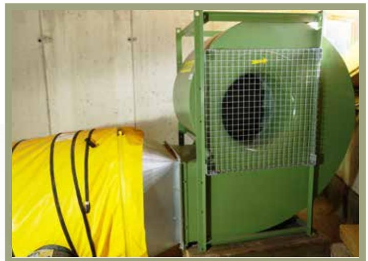
*Je nach Trocknungsanforderung werden direkt geflanschte bzw. keilriemenbetriebene Ventilatoren ausgewählt.*
