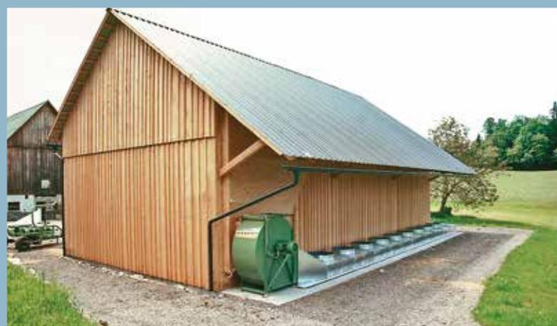
Einreihige Blechkanaltrocknung mit Dachraumabsaugung.
