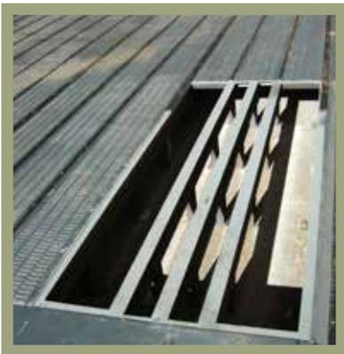
*Die Kiemenblechtrocknung ist je nach Unterkonstruktion befahrbar*
